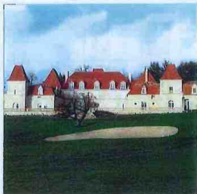
Château des Vigiers (24)
