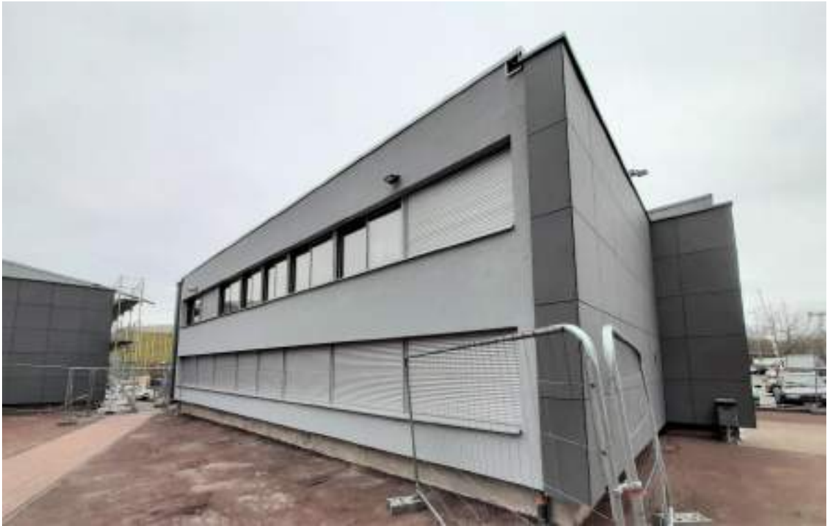
Internat du lycée La Fayette à Clermont-Ferrand / Région Auvergne-Rhône-Alpes
