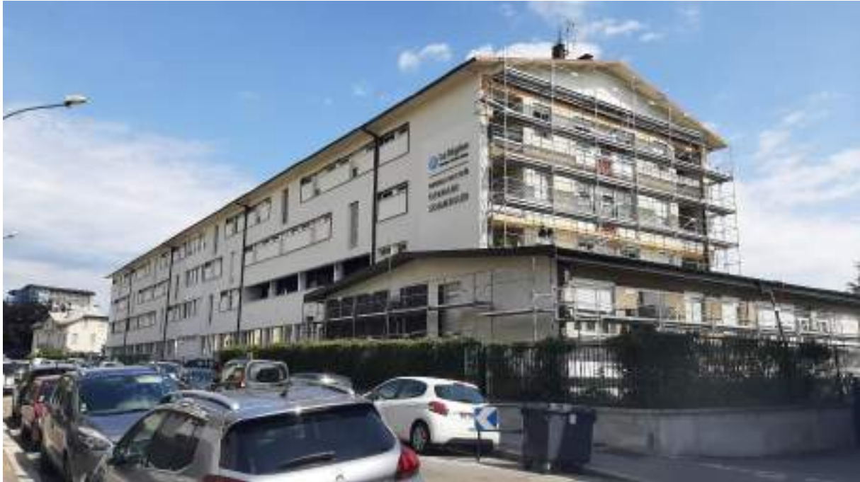
Internat du Lycée Germain Sommeiller à Anney / Région Auvergne-Rhône-Alpes Réduction des consommations énergétiques de 40%
